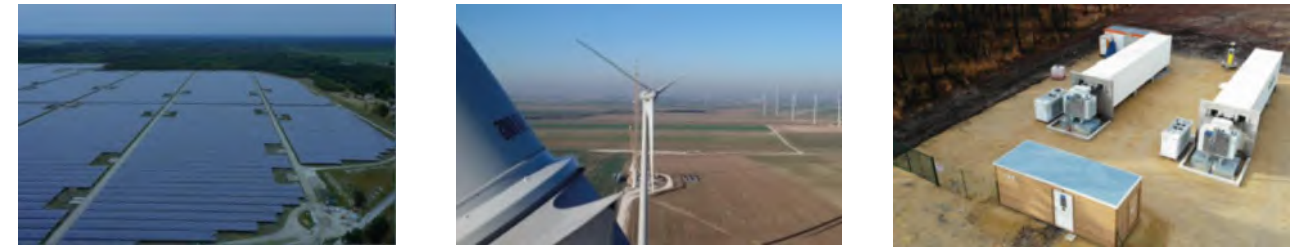
Figure 15 : de gauche à droite, Centrale Solaire de Cestas (300 MWc), Centrale Eolienne de Bussy-Létrée (26 MW), et Azur Stockage (6 MW, 6MWh) (source : NEOEN, 2019)
