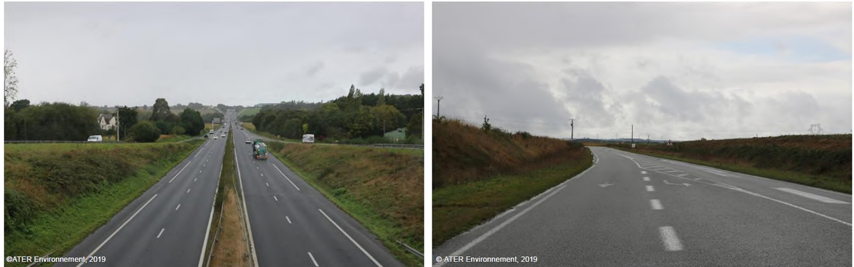
Figure 29 : A gauche ; La N12-E50 à son intersection avec la D14 à la sortie sud de Lamballe / Adroite : La D792 au niveau du hameau St Mirel
