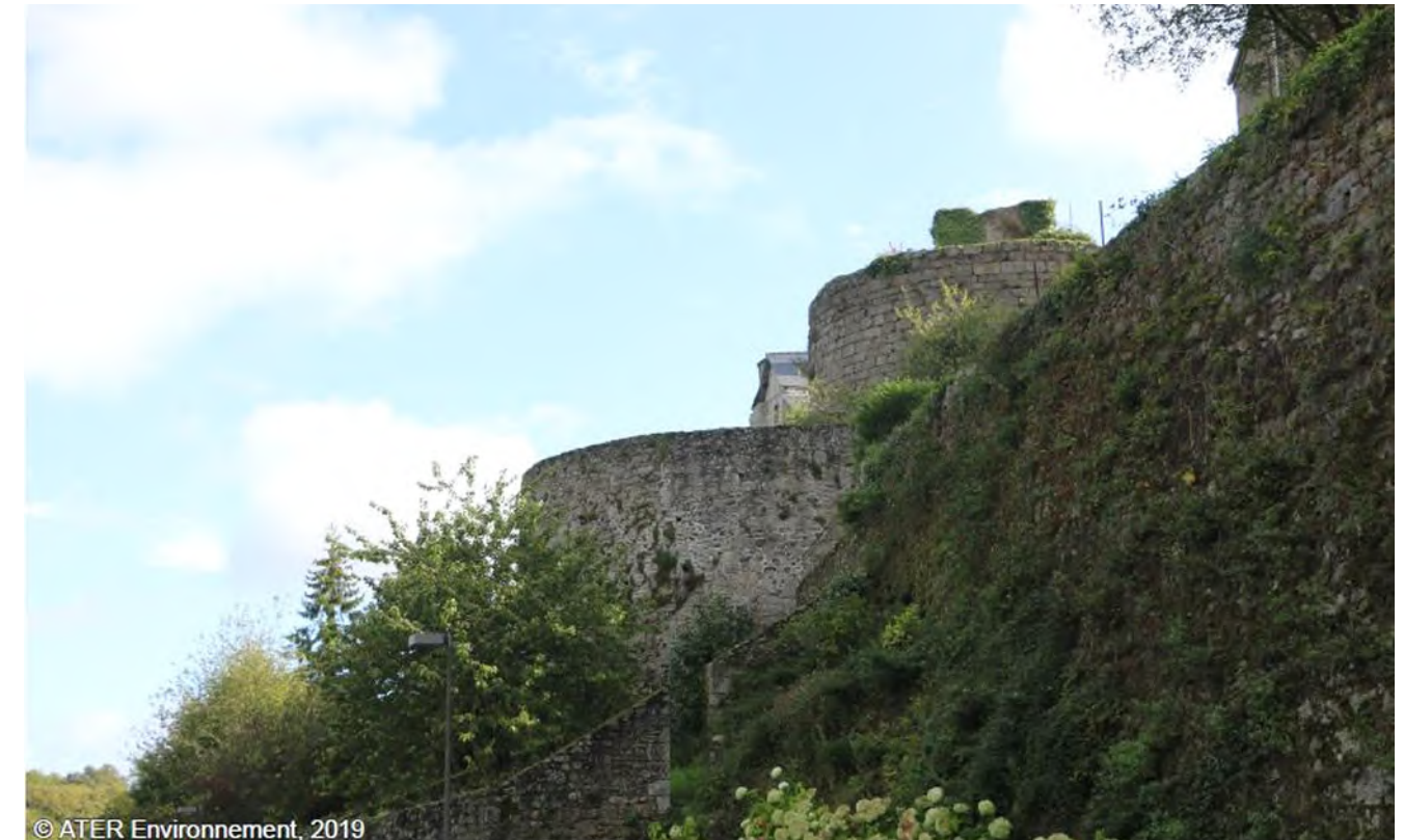
Figure 62 : Remparts et tour d'enceinte
